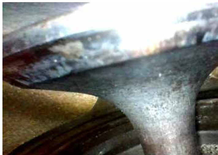
Foto ovan: Inspektion av ventil
